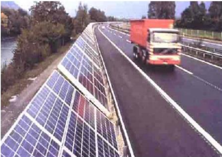
Esempio di barriera antirumore fotovoltaica
